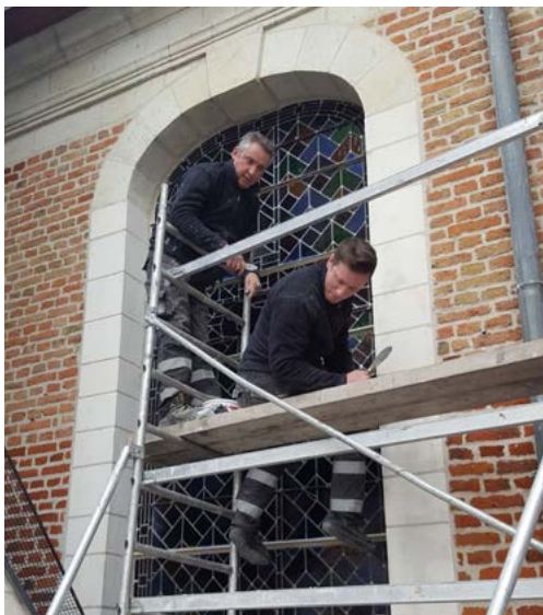
Réparation d'un vitrail de l'église St Michel et pose d'une protection
