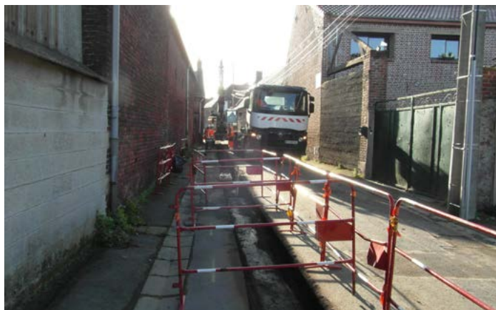
Chemin des Ruelles - Travaux de défense incendie et réseau d'eau potable
