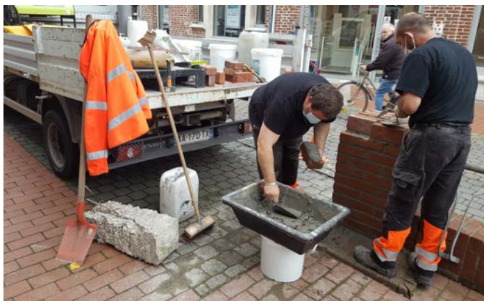
Remise en état d'un muret rue Lanoy par nos agents du Centre Technique Municipal
