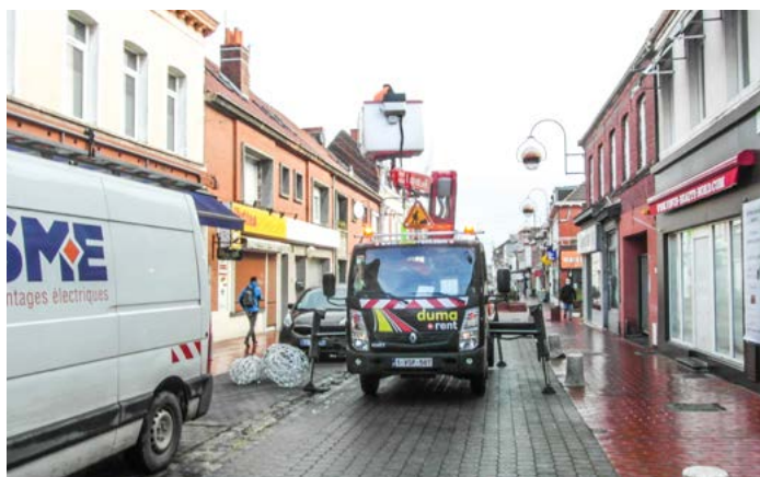
Pose des illuminations de Noël par la société SME
