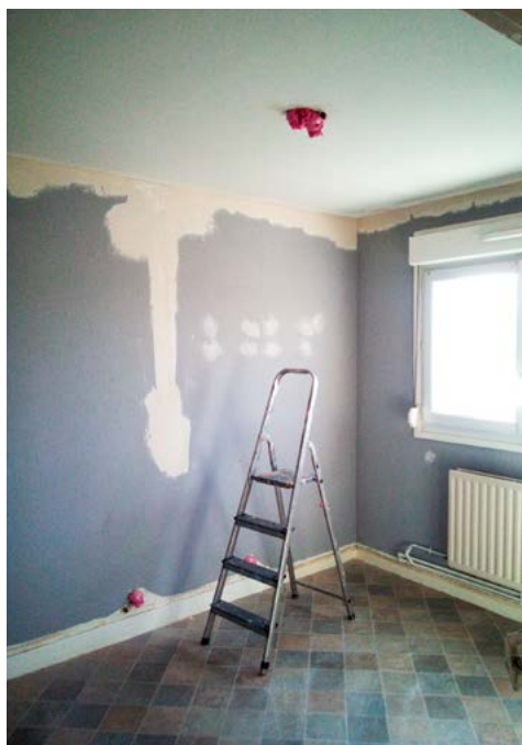
Réhabilitation du logement au Foyer Culturel Municipal Henri Martel.
