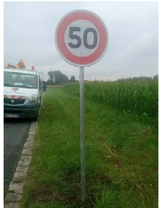
Installation d'un panneau de limitation de vitesse rue du Prétolu.
